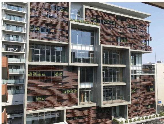
フレームの積層とガラスファサード
